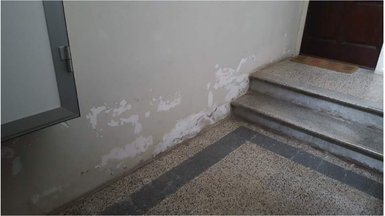
VANO SCALE, INGRESSO
