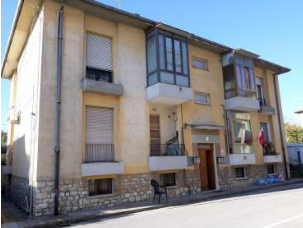
3 – FRONTE VIA NINO BIXIO
