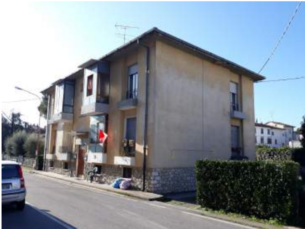
2 – FRONTE VIA NINO BIXIO
