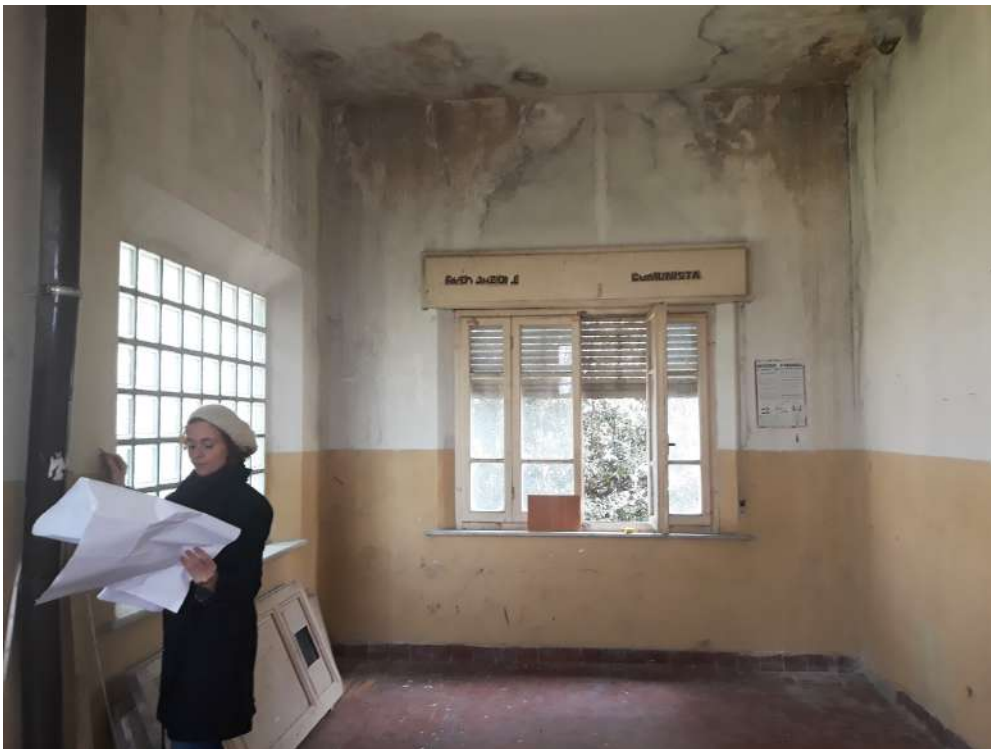
Foto 6 Interno piano primo
