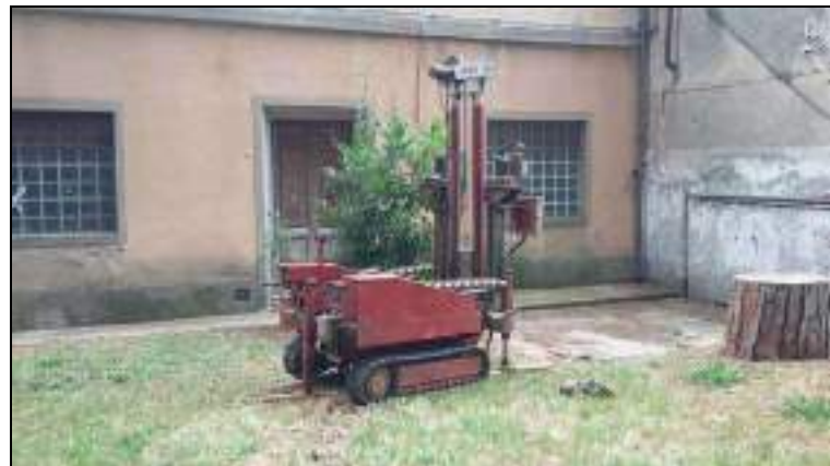
POSTAZIONE PENETROMETRIA CPT DI FRONTE AL FABBRICATO DI PROGETTO
