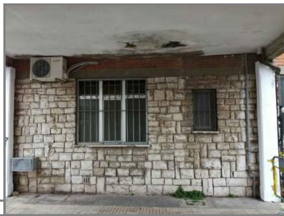
1 Parete lato Sud con servizi da rimuovere o confinare
