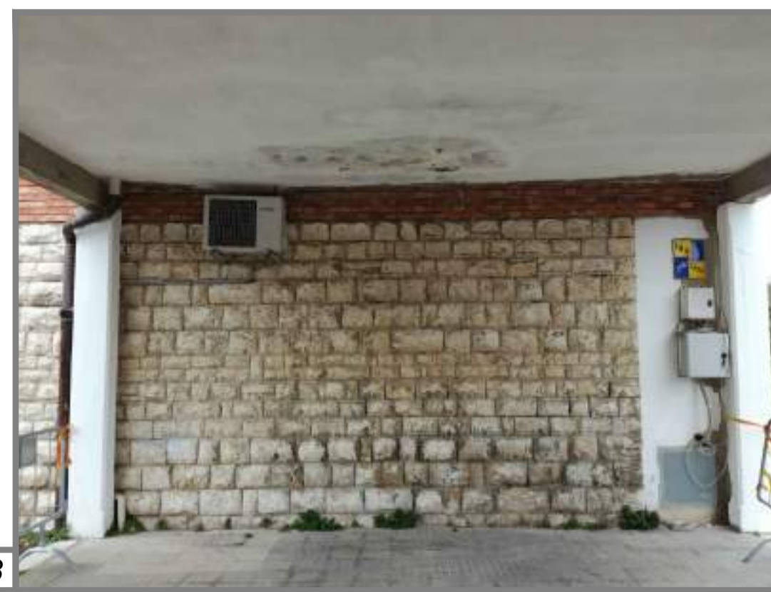
3 Parete lato Nord con servizi da rimuovere o confinare
