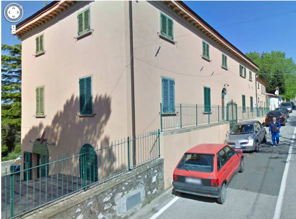
Figura 3- vista da via Roma
