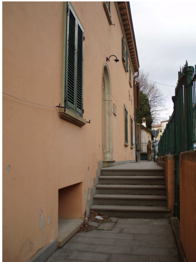
Figura 4- particolare scale esterne dal resede del piano seminterrato al piano terra quota strada
