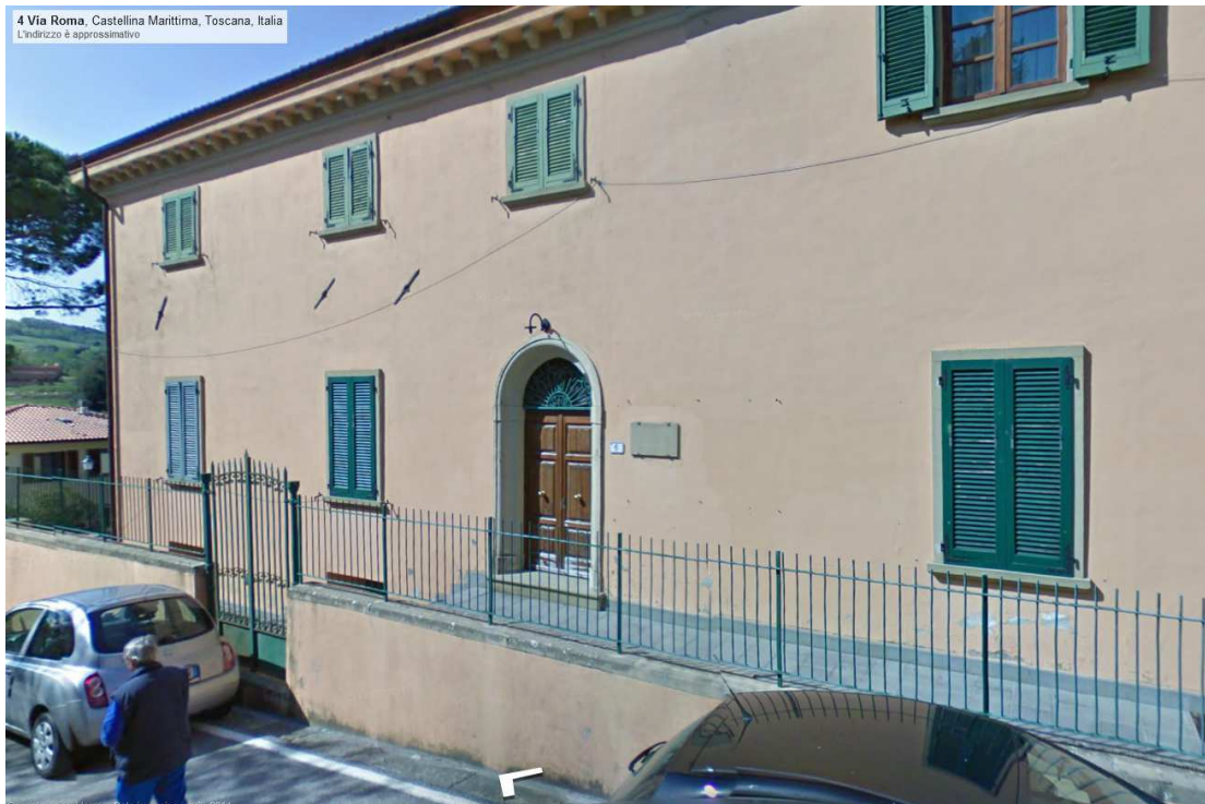
Figura 1-vista da via Roma
