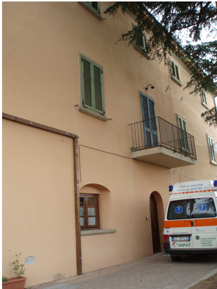
Figura 5- particolare della facciata sul retro che guarda il resede esterno lato ovest
