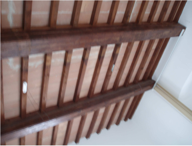
Figura 7- particolare dei solai lignei calpestio piano primo e copertura
