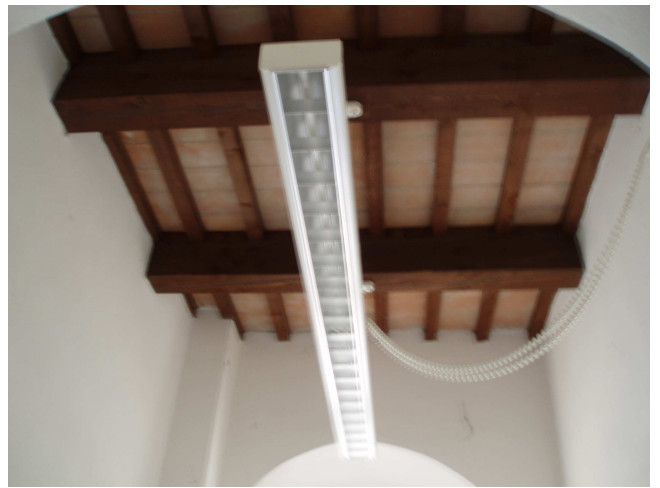
Figura 7- particolare dei solai lignei calpestio piano primo e copertura
