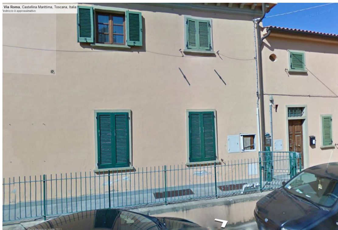
Figura 2-vista da via Roma
