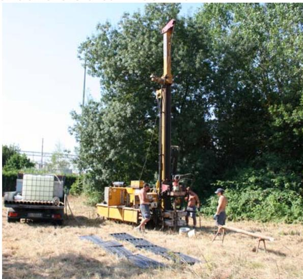
*Fig 3 La sonda Massenza durante l'esecuzione del sondaggio S1.*
