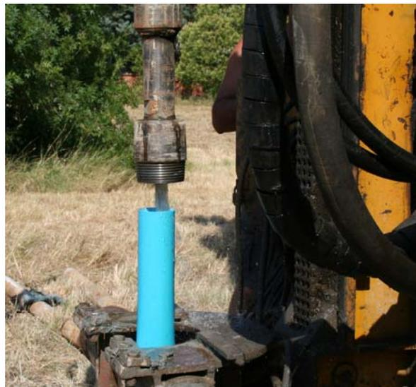
*Fig 4 Particolare della fase di posizionamento del tubo cieco per l'esecuzione della prova sismica in foro..*
