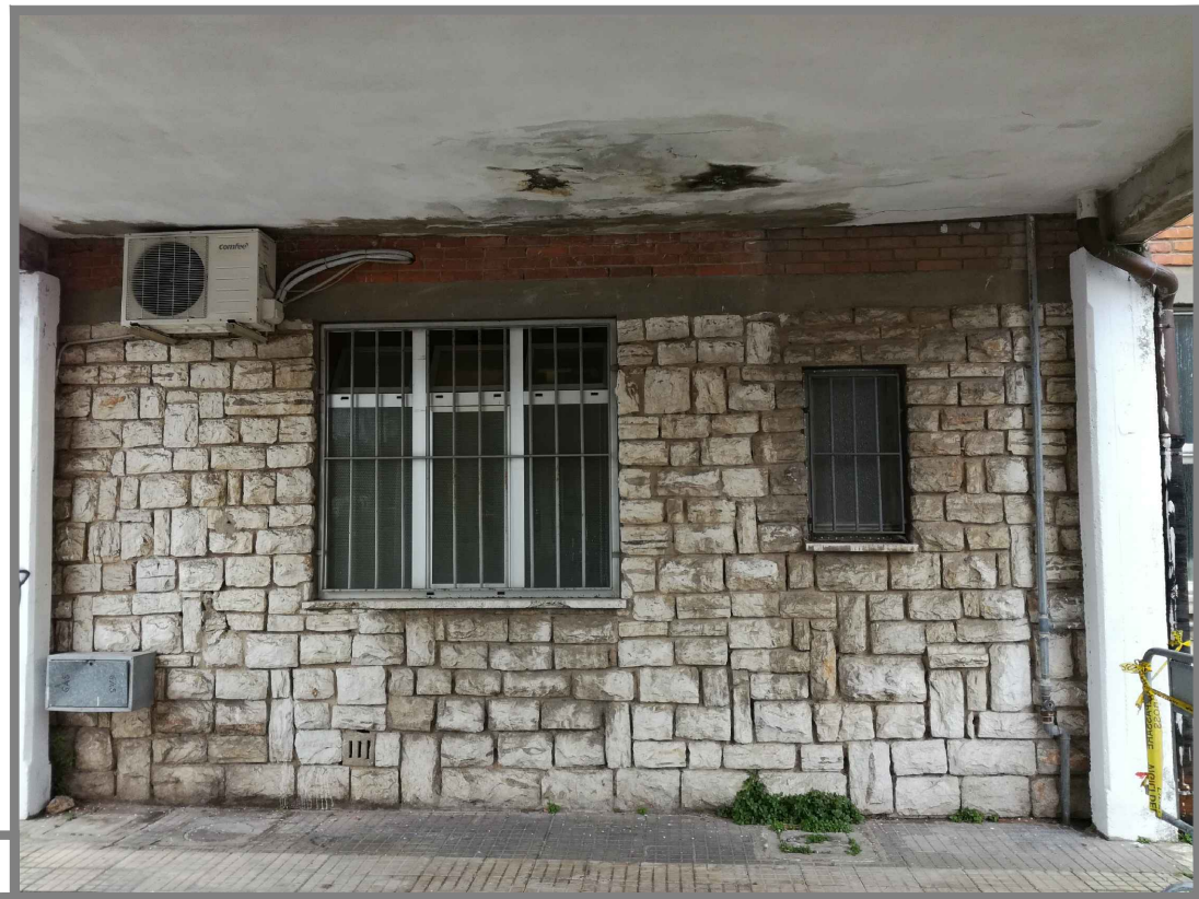
Parete lato Sud con servizi da rimuovere o confinare
