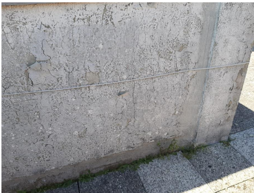
FOTO N. 5 foto parapetti da trattare
