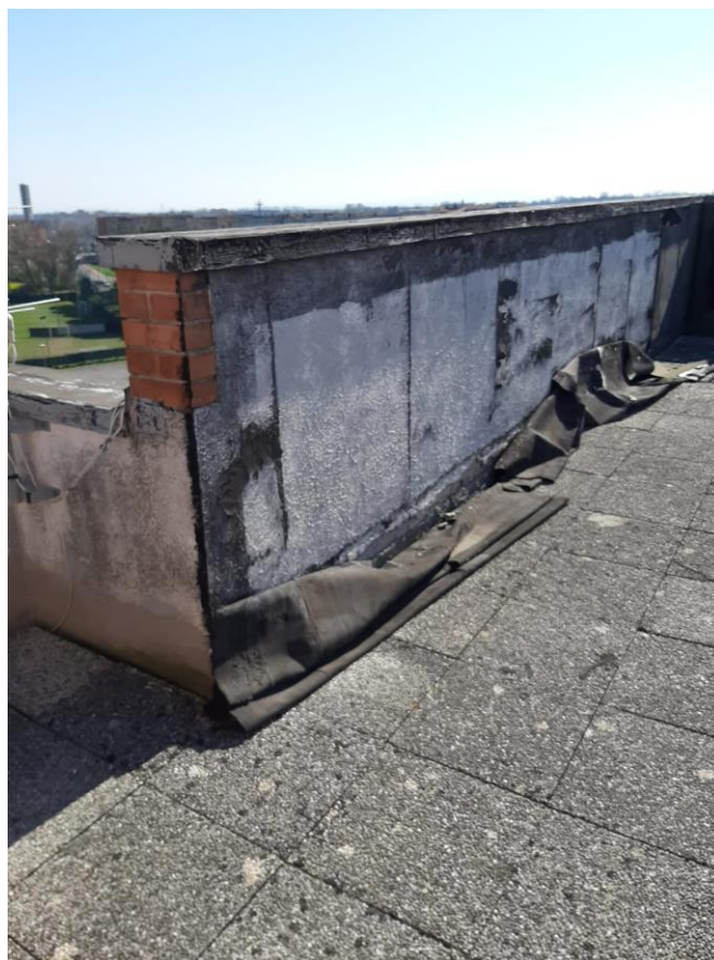
FOTO N. 8 foto parapetti da trattare
