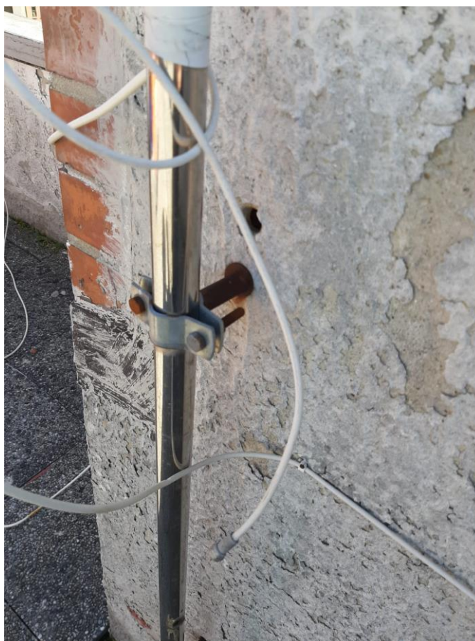
FOTO N. 6 foto parapetti da trattare
