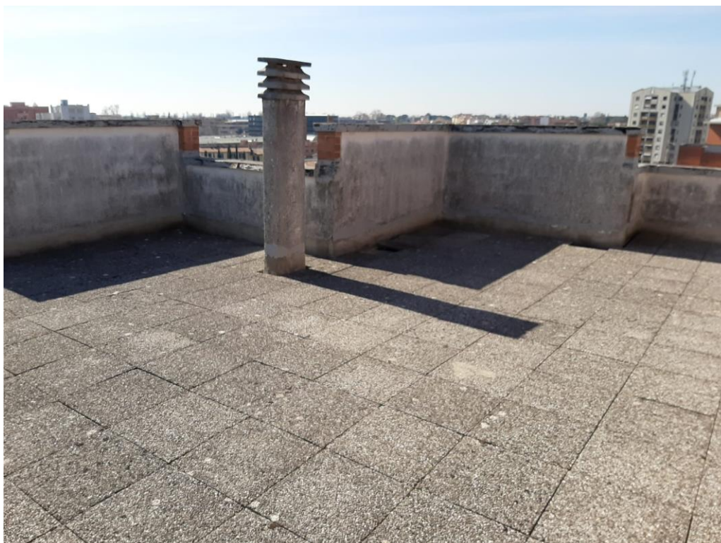
FOTO N. 6 foto panoramica della copertura e dei parapetti
