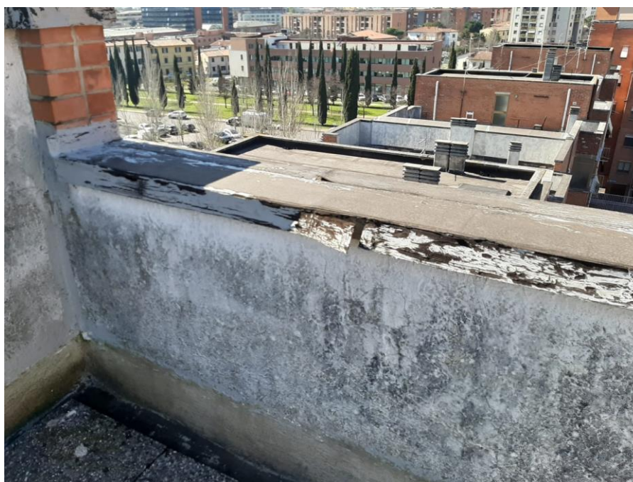
FOTO N.9 foto parapetti da trattare
