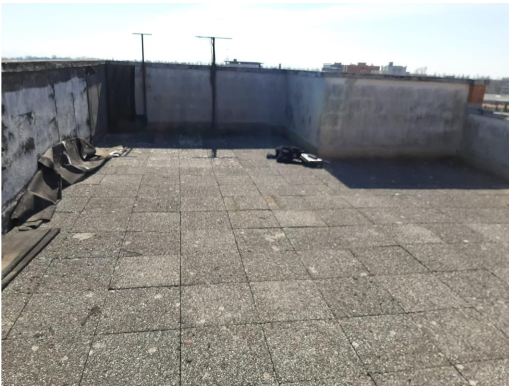
FOTO N. 5 foto panoramica della copertura e dei parapetti
