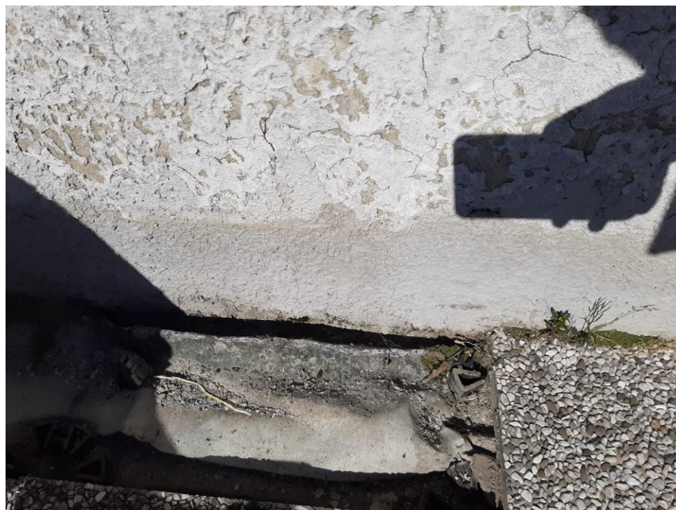
FOTO N. 4 foto tnt da rimuovere delle copertura piana
