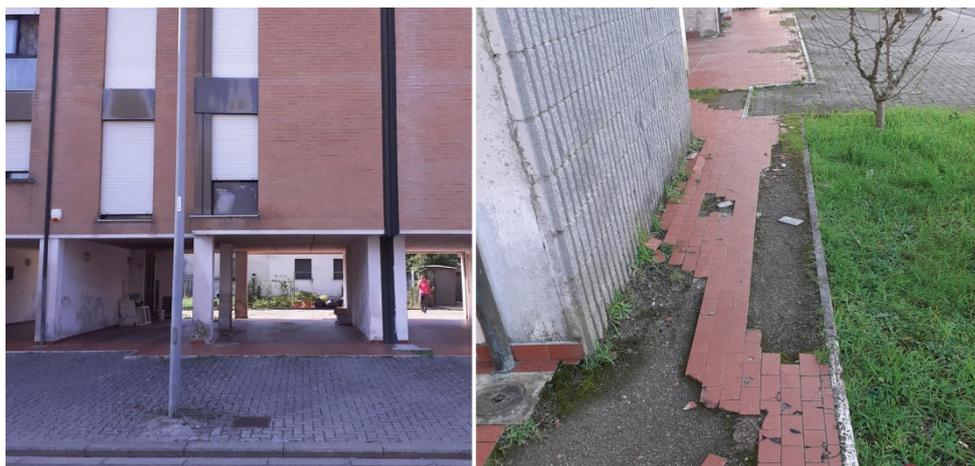
L'intervento consiste nella demolizione della pavimentazione esterna e della sottostante malta di allettamento, fino a cm. 10 dall'attuale livello, al fine di realizzare lo spessore necessario alla creazione della nuova soletta armata e della successiva pavimentazione, in piastrelle di gres spessorate, posate lineari a correre e con scala di scivolosità minima R11.
