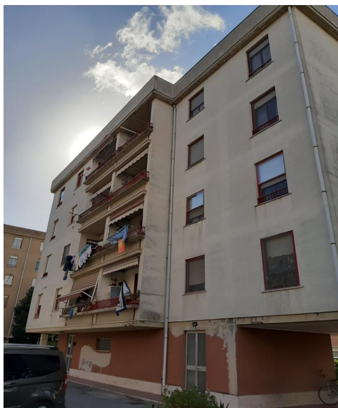
FOTO N. 4 angolo prospetto lato Sud-Est
