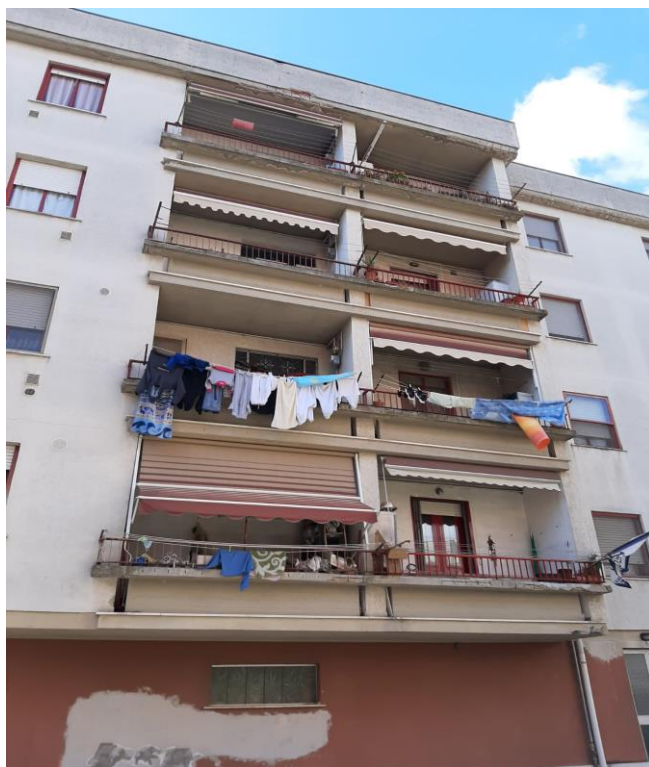
FOTO N. 3 particolare aggetti terrazzi prospetto lato Sud
