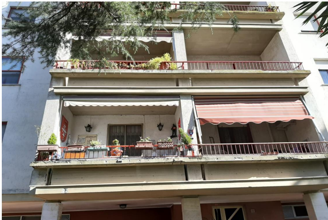
FOTO N. 1 prospetto lato Nord
