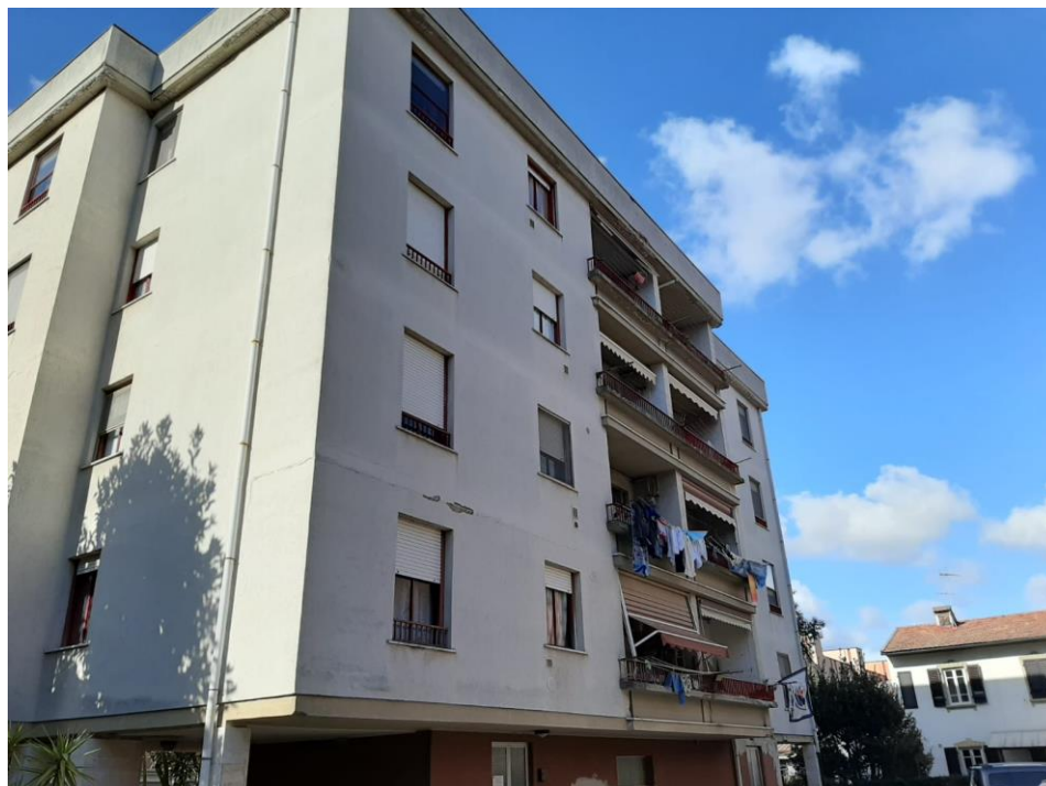
FOTO N. 2 prospetto lato Sud
