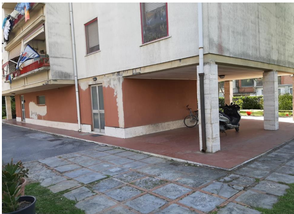
FOTO N. 5 prospetto lato Est
