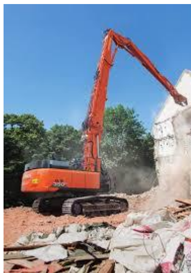
Foto 8. Esempio di macchina dotata di pinze idrauliche per le grosse demolizioni.
