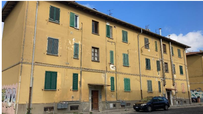
Foto 3. Fabbricato di via Sirtori 11-12.
