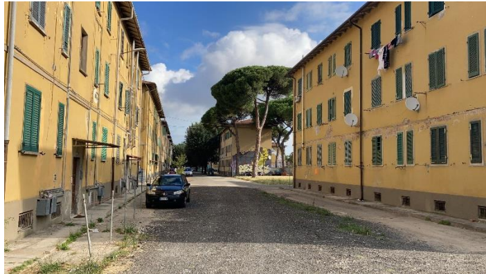
Foto 2. Tre fabbricati oggetto di demolizione.
