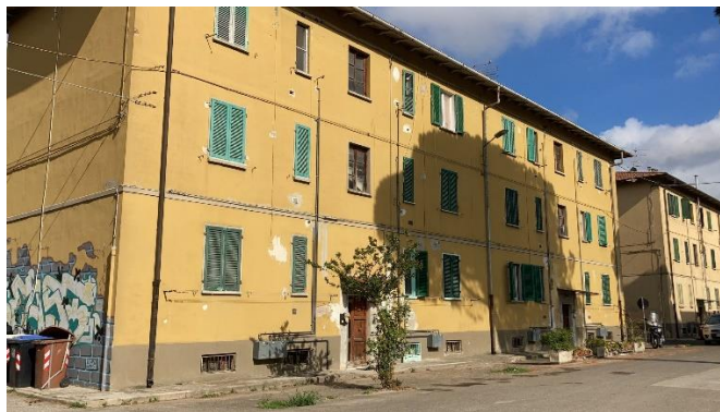
Foto 5. Fabbricato di via Sirtori 9-10.
