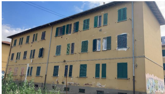
Foto 4. Fabbricato di via Sirtori 11-12.
