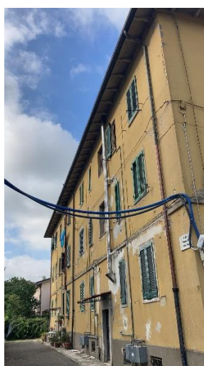
Foto 6. Prospetto est fabbricato di via Verità 7-8.
