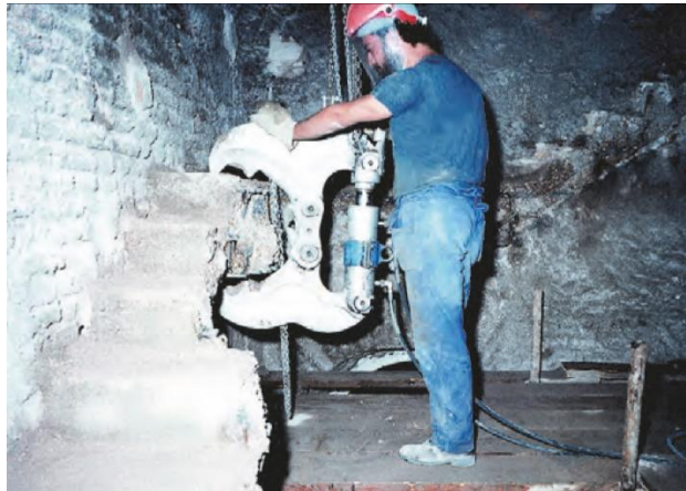
Foto 7. Esempio di macchina manuale utilizzata per lo più per le demolizioni di interni.
