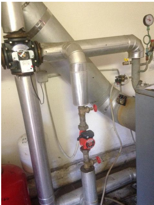
Figura 1.1- Valvola a tre vie in C.T.
